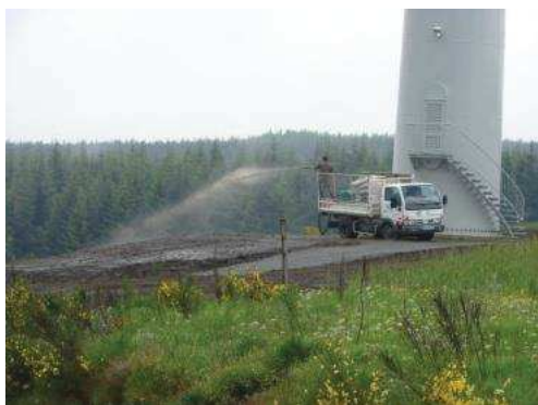
Revégétalisation par d'hydroseeding
